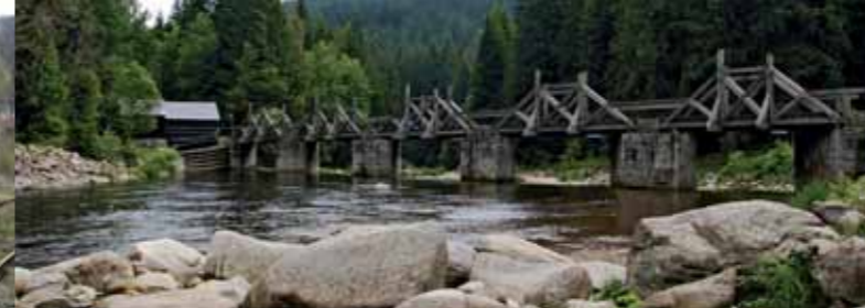
▲ CZ Rechle – hradlový most na řece Vydře je místem, kde začíná náhon Vchynicko-tetovského plavebního kanálu. / DE Rechle – die Stellbrücke am Fluß Vydra ist die Stelle, wo der Mühlgraben des Vchynicko-tetovsky Schwemmkanals beginnt. / EN The Rechle gate bridge on the river Vydra is a place where the headrace for Vchynicko-tetovsky floating channel begins.
